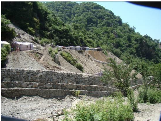
照2-13 1-2 号坑口渣坡及铁丝网挡墙
