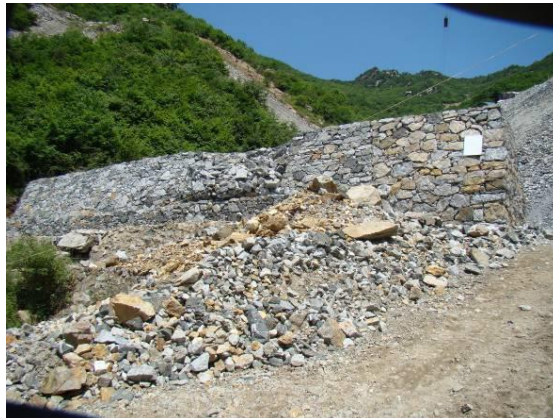
照2-14 风门1-5 号硐口铁丝网挡墙
