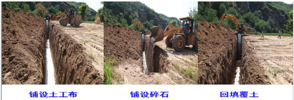
图 3 羊圈沟地下排水工程示范
