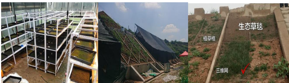
图 6 多植被类型的边坡生物防治技术示范
