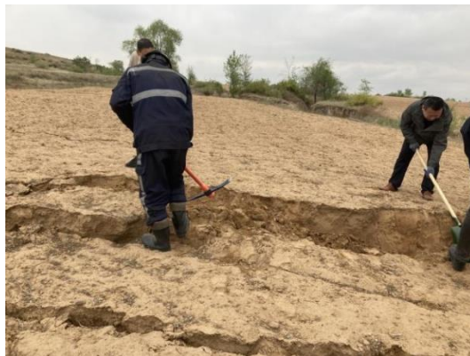
照片 2.6-2 裂缝治理中
