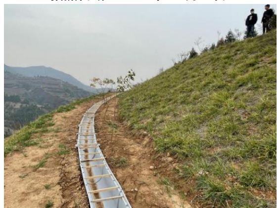
照片 3-13 泗洲庙排矸场马道截水渠 （镜向：SW）拍摄日期：2024 年 11 月 8 日
