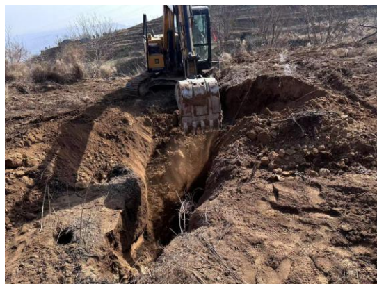
照片 2-28 地裂缝治理中
