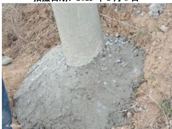
照片 2-21 治理后电杆 拍摄日期：2023 年 2 月 15 日
