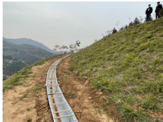
照片 2-18 泗洲庙排矸场马道截水渠（镜向：SW）拍摄日期：2024 年 11 月 8 日
