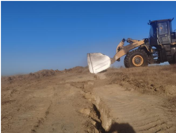
照片 2.6-32 塌陷区裂缝充填（镜向 S）
