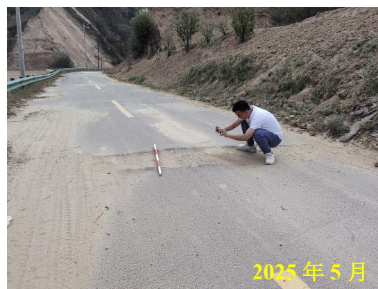
照片 3.2-19 地面塌陷 TX7 伴生地裂缝(镜向 NW) 照片 3.2-20 地面塌陷 TX7 损毁道路(镜向 NE)
