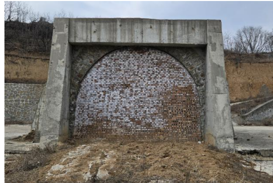
照片 2.39 回风斜井封堵后（镜像 70°）
