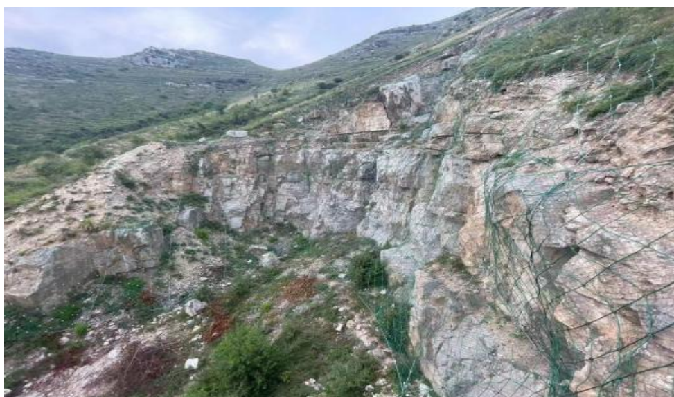
照片 2-19 废弃采坑主动防护网治理工程（2022）
