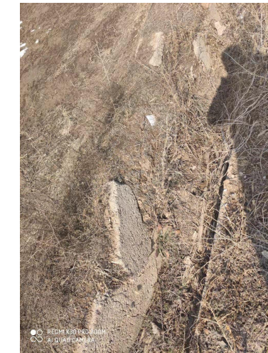
照片 3.3-4 水渠开裂（镜向 S）
