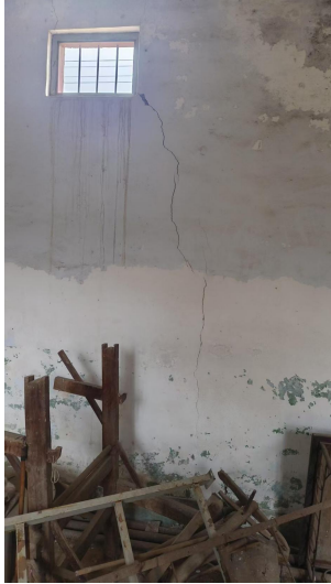
照片 3.2-10 曹庄村房屋 裂缝（镜向 S）
