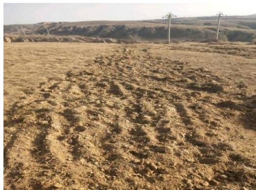
照片 2.6-28 沉陷土地裂缝充填
