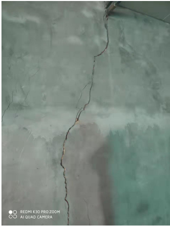
照片 3.2-2 沉陷损毁房屋现状（镜向 NE）
