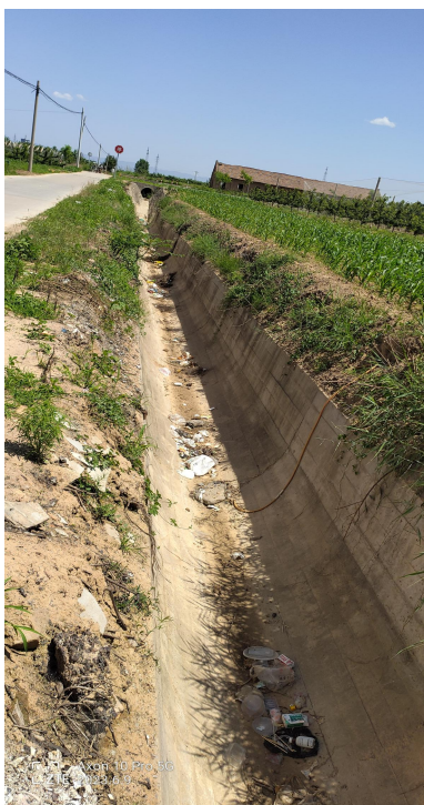
照片 2.1-1 八支渠（混凝土预制板）（镜向 NE）
