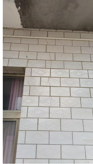
照片 3.2-11 曹庄村房屋 裂缝（镜向 E）
