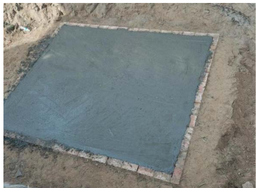
照片 2.6-8 公社窑立井封闭照片
