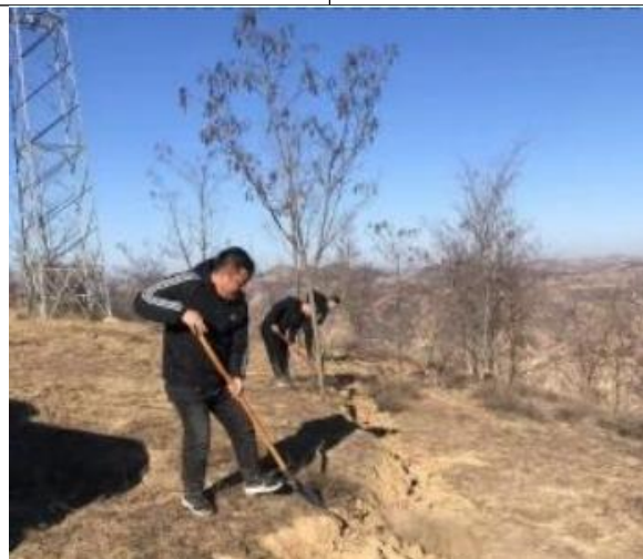
照片 2.6-10 地表裂缝治理（镜向 S）
