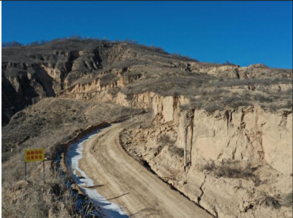
照片 3.2-3 公路裂缝（镜向 NW）
