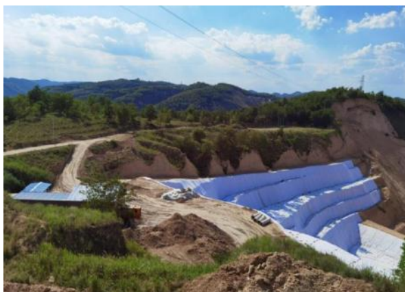
照片 2.6-17 矸石周转场防治工程（镜向 W）
