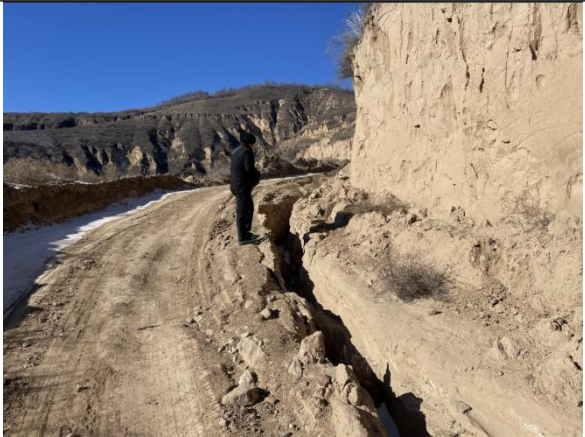
照片 3.2-4 油井道路裂缝（镜向 NW）
