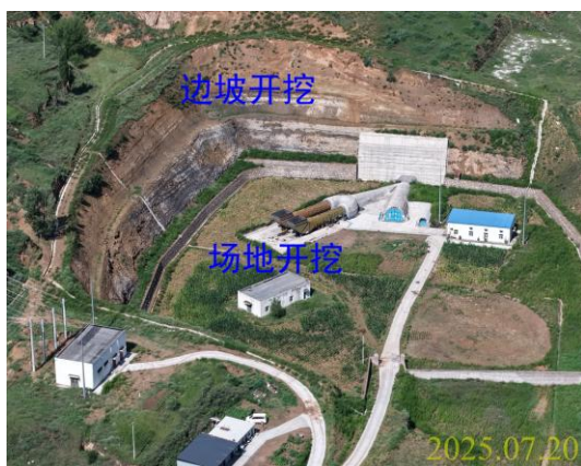
照片 3.2-30 风井场地填平及边坡开挖（镜向W）
