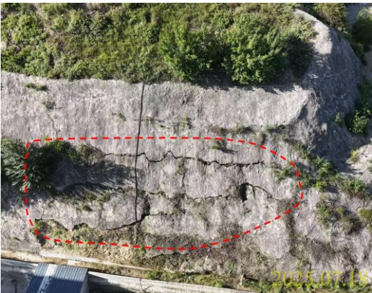
照片 3.2-17 不稳定斜坡坡面开裂（镜向N）
