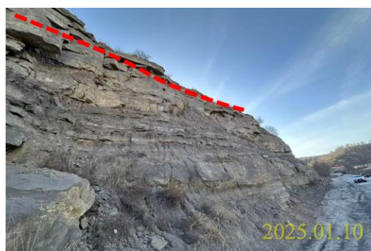
照片 3.2-9 庙羊路K7+800 崩塌（镜向NW）
