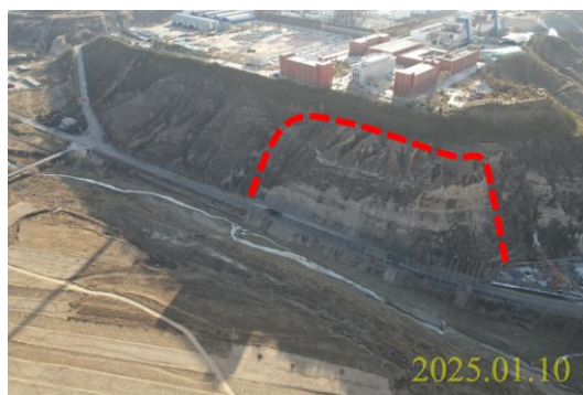
照片 3.2-2 后沟门边底线公路崩塌（镜向 SW）
