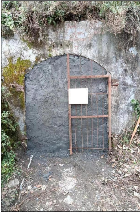
照片 2-6 665 硐口封堵照片
