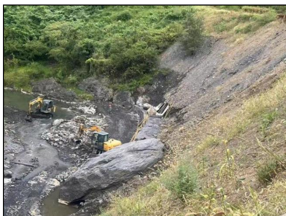
照片 2-13 ZD2 渣堆挡墙修复治理前（镜向 20°）照片 2-14 治理后（上游段）（镜向 45°）
