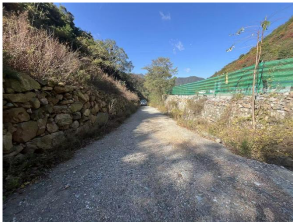
照片 2-14 路面修复和干砌石挡墙
