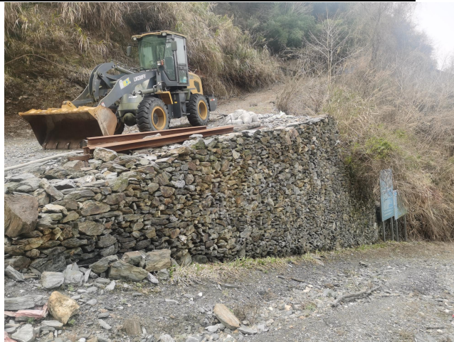
照片 2-23 矿山道路 1 边坡加固后
