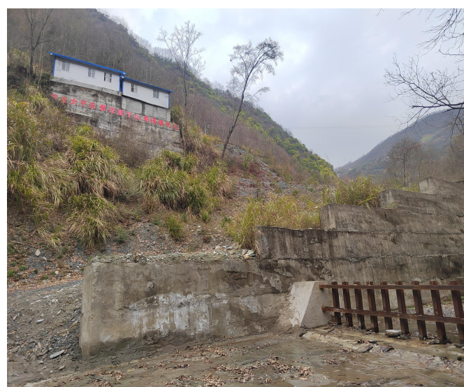
照片 2-21 Z4 废渣堆拦渣坝修筑后
