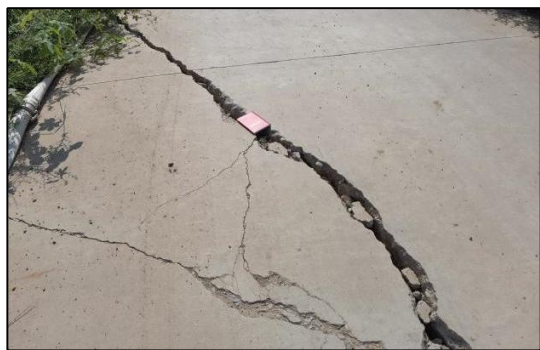
照片 3.2-26 3401 工作面裂缝（镜像 20°）
