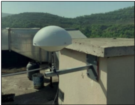
照片 5.6-4 主楼 GNSS 安装
