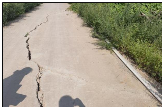
照片 3.2-27 3401 工作面裂缝（镜像 330°）
