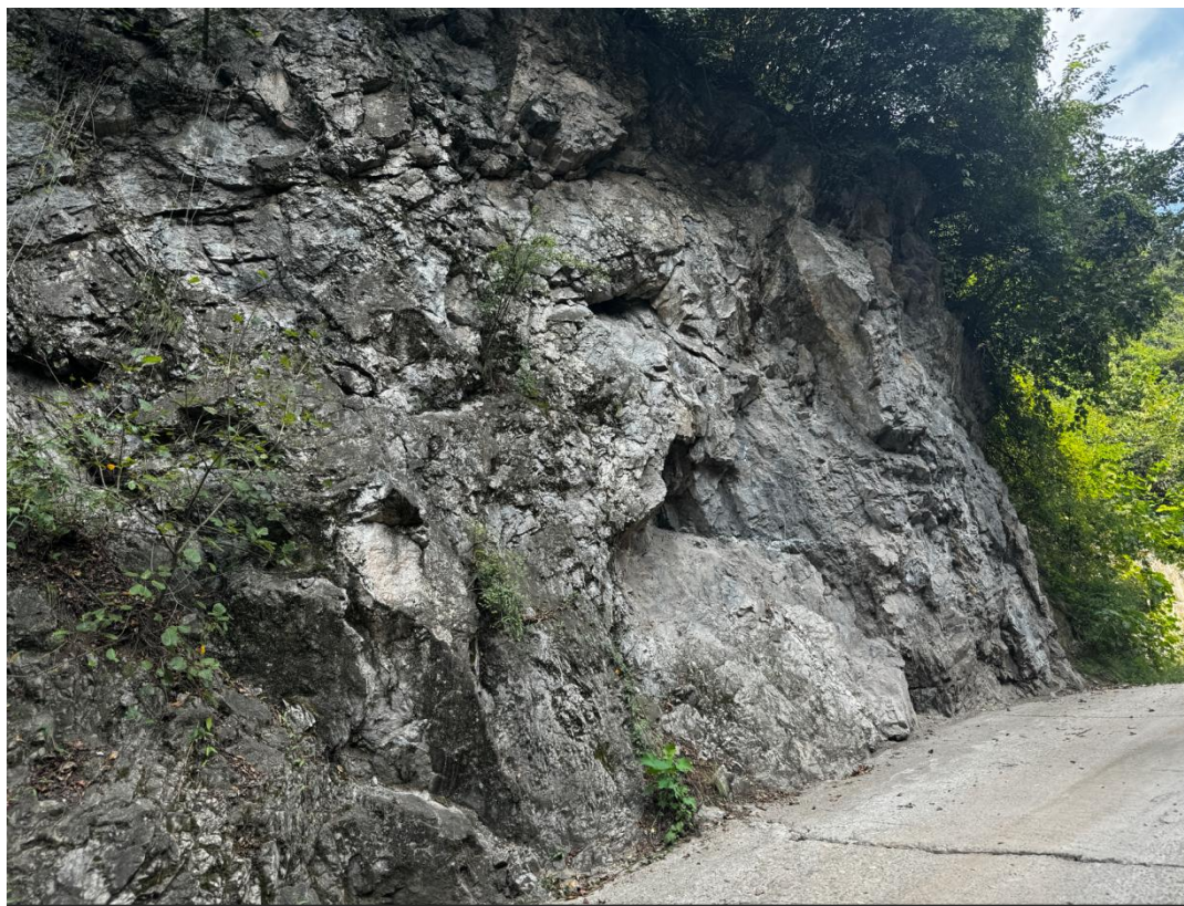
照片 2-9 道路切坡形成不稳定边坡（镜像 NW）
