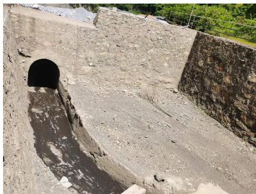
照片 2-13 场地排水渠及拦挡工程
