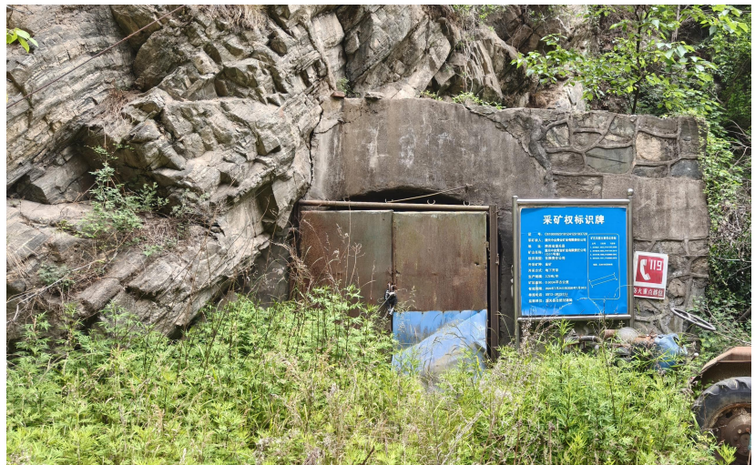
照片 3.2-2 679 主平硐（东）硐口北侧危岩
