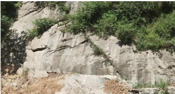
照片 2.2-1 洞口场地西侧太古界太华群洞沟组片麻岩（270°）
