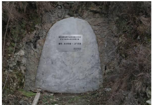
照片 1.4-4 755 平硐已封堵（镜向 100°）
