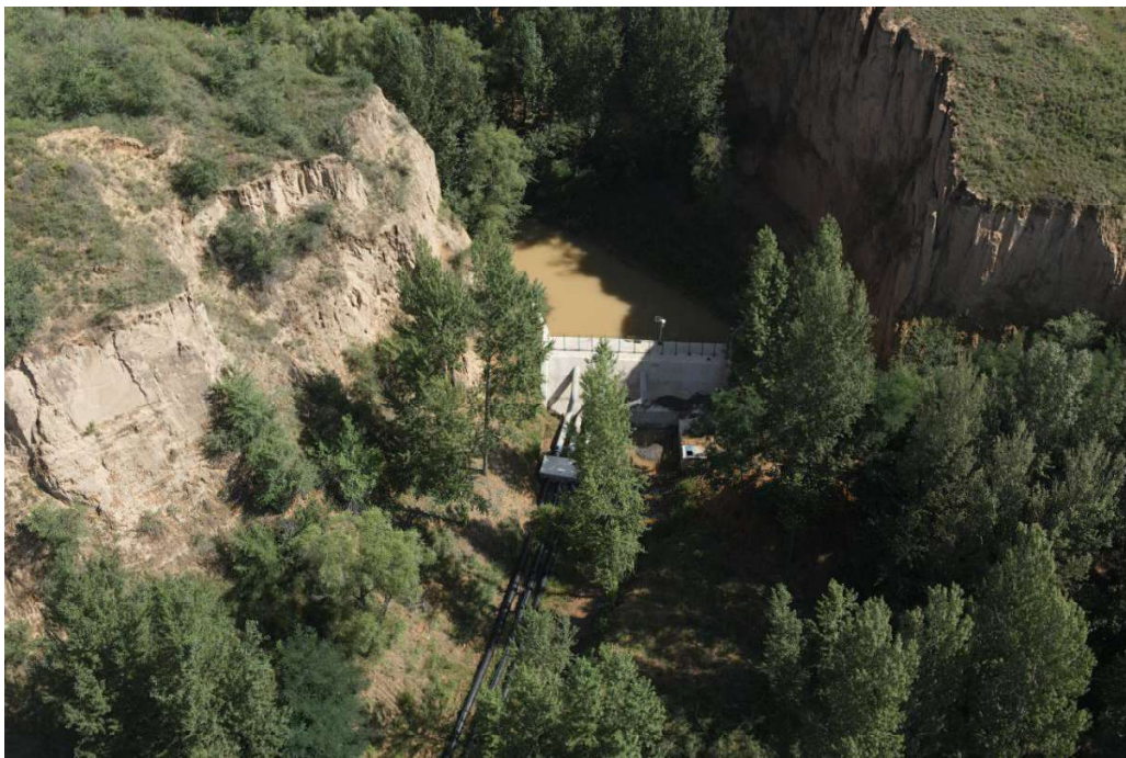
照片 2.6-18 沙界沟上游设置的拦水坝
