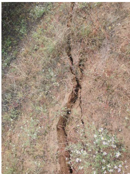
照片 2.6-1 3101、3102 工作面裂缝治理前
