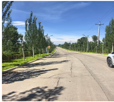
照片 3.2-2 塌陷区道路裂缝（镜向 N）
