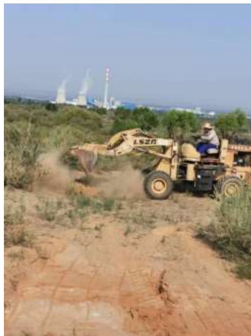
照片 2.6-9 裂缝治理中 (1)
