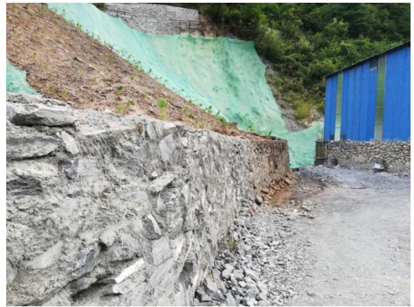
照片 2-11 2号废石场拦挡墙
