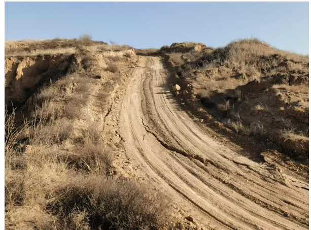
照片 3.2-4 TX2 塌陷区域道路裂缝
