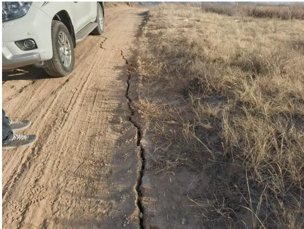
照片 3.2-3 TX1 塌陷区域道路裂缝
